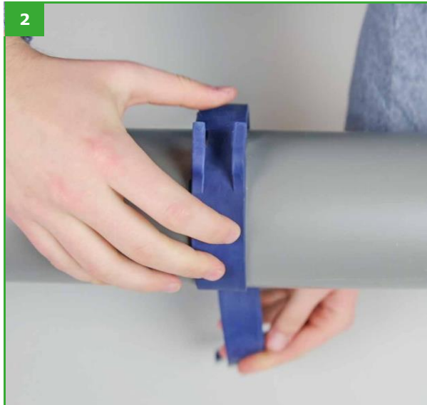
Plaats de band van de UFO-sluitstrip rond de rioolbuis (buitendiameter van 110 - 125mm).
